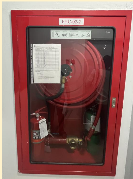
ตู้สายฉีดน้ำดับเพลิง
