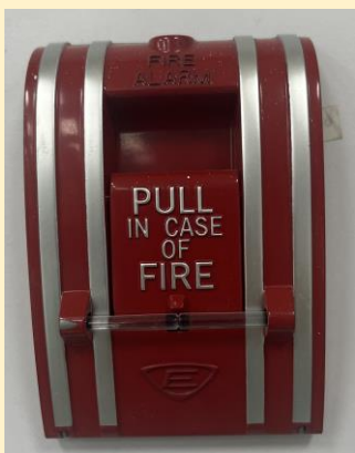
ระบบแจ้งเหตุเพลิงไหม้ด้วยมือ
